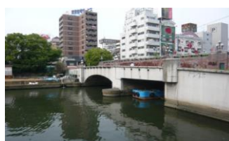
▲ 架替前の大黒橋と可動堰
