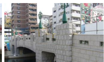
▲ 完成後の大黒橋（側面部）
