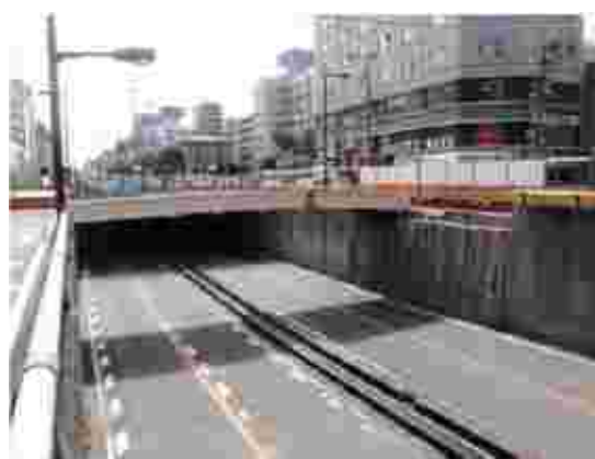
▲ 新橋架設後の状況
