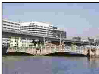
▲大江橋 (重要文化財・土木遺産)
