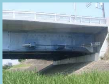
落橋防止装置設置
