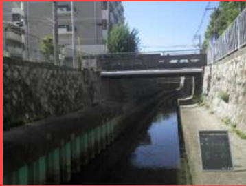
橋梁の架け替え工事 (駒川 9 号橋：工事着手前)
