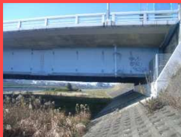
耐震対策工事 (吾彦大橋：工事着手前)
