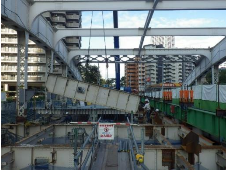
▲床組（鋼桁）撤去工
