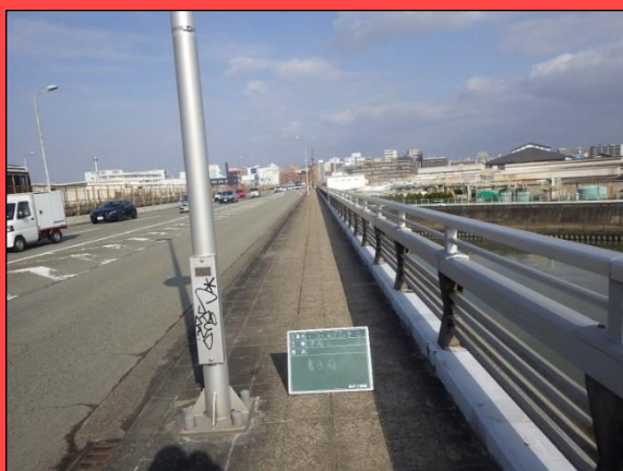
▲歩道拡幅工事 (十八条大橋：工事着手前)
