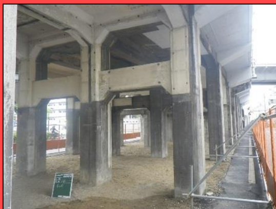
▲耐震対策工事 (北方貨物線高架橋：工事着手前)
