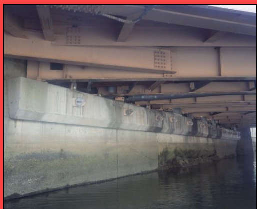
▲津波対策工事 (岩崎橋：工事着手前)
