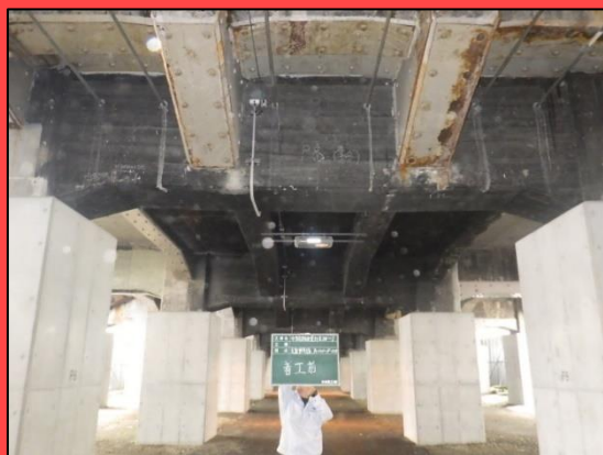
▲耐震対策工事(鋼板接着) (中津高架橋：工事着手前)
