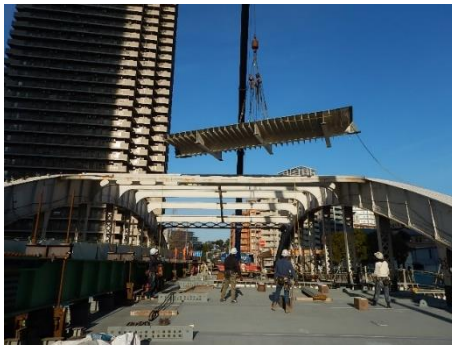
▲鋼製床組架設工
