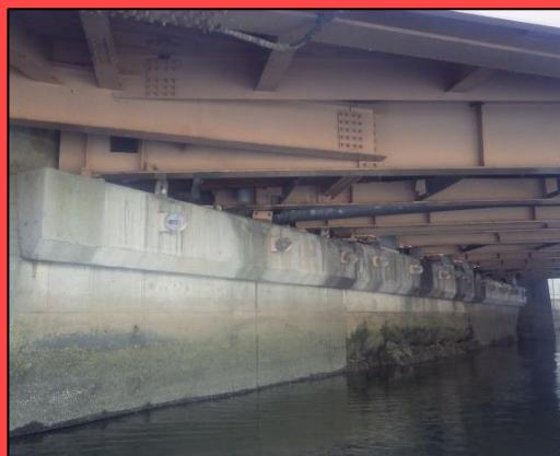
▲津波対策工事 (岩崎橋：工事着手前)
