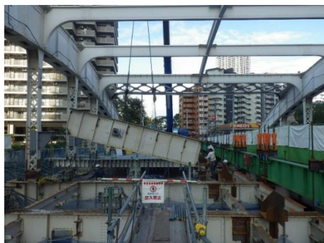
▲床組（鋼桁）撤去工
