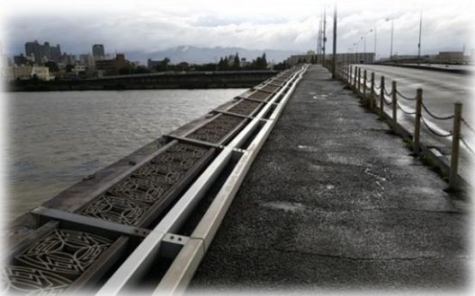
▲台風により倒れてしまった高欄
