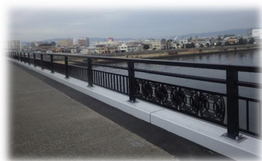
▲復旧工事完了後の新しい高欄
