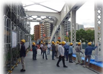
▲堂島大橋(工事中)見学コース
