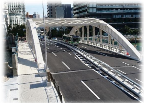
▲⑧工事完了後の様子
