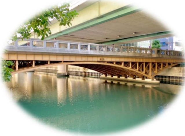
橋長：57.0m 幅員：12.7m
