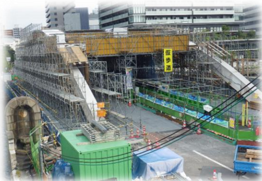
▲⑥塗装塗替の足場が組まれた様子
