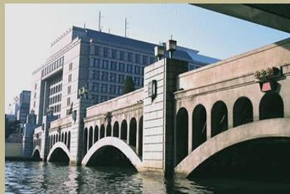
もとは橋ではなく、水質浄化のための可動堰であった。かつては堰を閉めて水を貯めた後、堰を開放し、一気に水を流すことで浄化していた。
