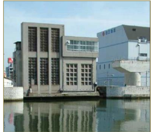
▲安治川トンネルタワー部（此花区側）
