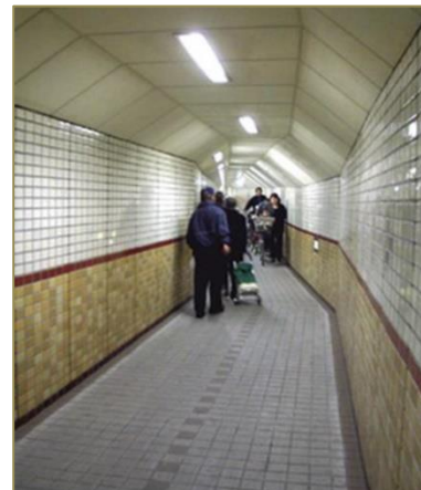
▲安治川トンネル内部
