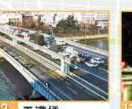
12 天满桥 1935年完工的钢铁拱桥。与新天满桥形成上下两层。被称为“天满二重桥”。难波三大桥之一。
