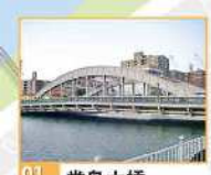
01 堂岛大桥 1927年建成的钢铁拱桥。战时曾遭受空袭，现在仍能看到空袭的痕迹。
