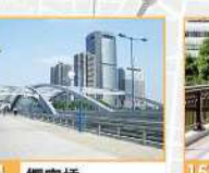
14 樱宫桥 通称“银桥”。完工之时1930年是日本最大的拱桥。2006年，北部相邻的新樱宫桥完工。
