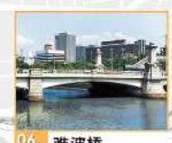
06 难波桥 1915年完工。1975年由原来的钢铁拱桥重新架成钢铁桥。通称“狮子桥”。难波三大桥之一。
