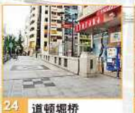
24 道顿堀桥 御堂筋道过道顿堀的桥。是大阪最宽阔的桥（桥宽43.6m）。1936年完工。
