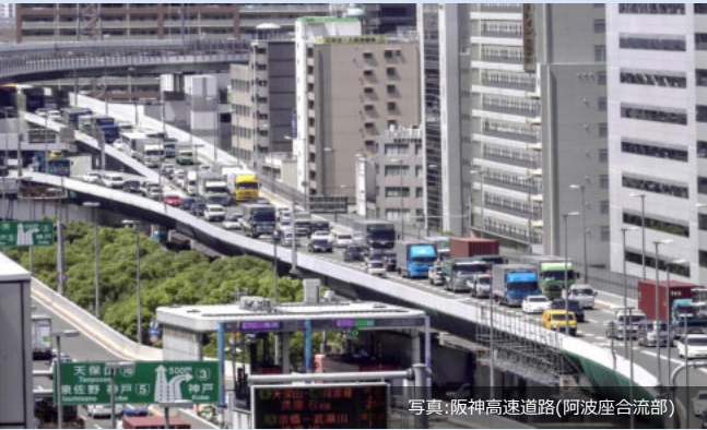
写真：阪神高速道路（阿波座合流部）
