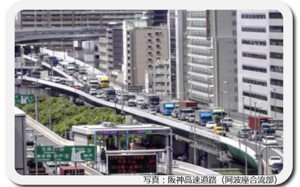
写真：阪神高速道路（阿波座合流部）
