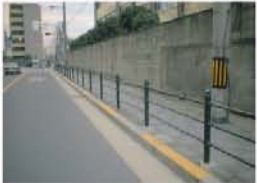
歩道全体が車道より高い構造
