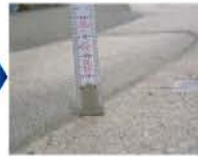
整備後(段差2cm)
