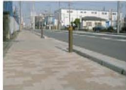
歩道と車道の境界ブロックが歩道面よりも高い構造
