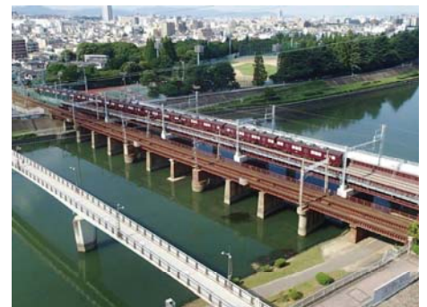
現在線を仮線に切替え、現在線跡地に高架橋を構築
