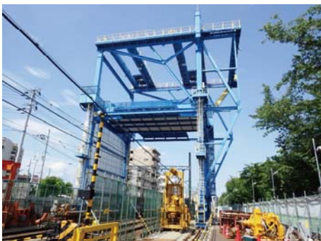
現在線を走らせながら高架橋を構築
