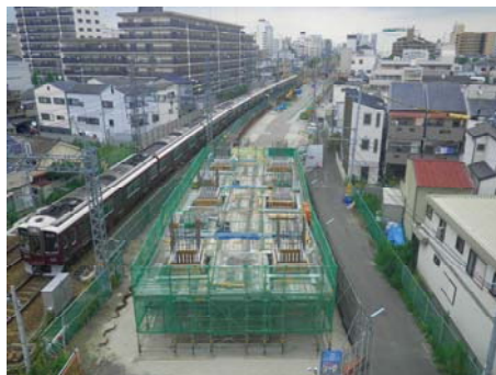
現在線横に高架橋を構築
