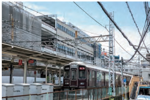
現在線横に高架橋を構築
