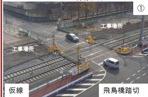
1 工区の現場状況
