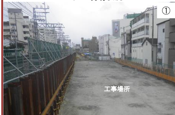
5 工区の現場状況
