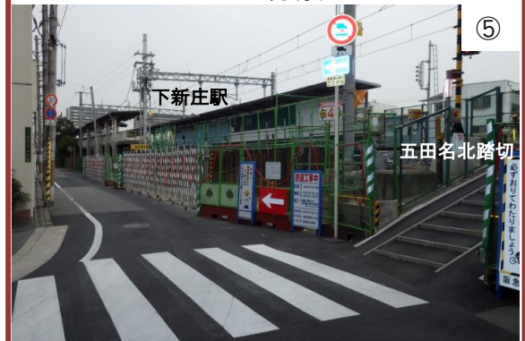
7 工区の現場状況
