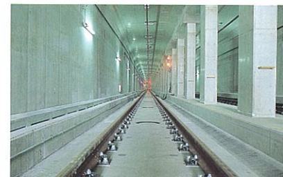
中間トンネル部
