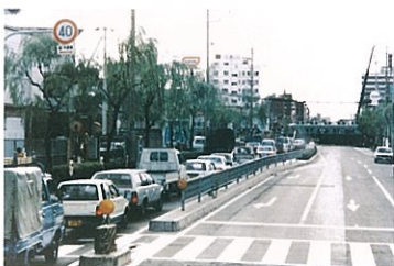
木津川平野線 (旧天下茶屋1号踏切) S57
