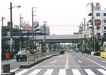
踏切除却後 H9
