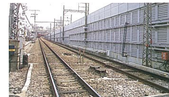
仮設工事(阿部野橋～河堀口間)
