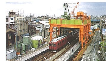
基礎杭工事(河堀口駅付近)
