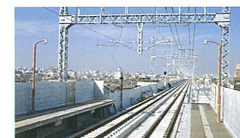
軌道電気工事(北田辺駅付近)
