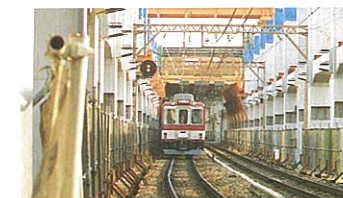
床版工事(河堀口～北田辺付近)
