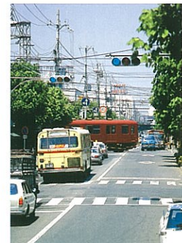
河堀口第3号踏切付近(工事着手前)
