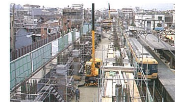
柱工事(今川駅付近)
