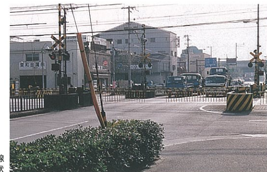
都市計画道路 淀川北岸線 大和田踏切の現状
