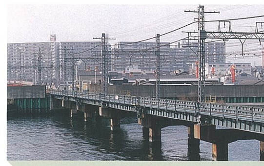
神崎川橋梁の現状
