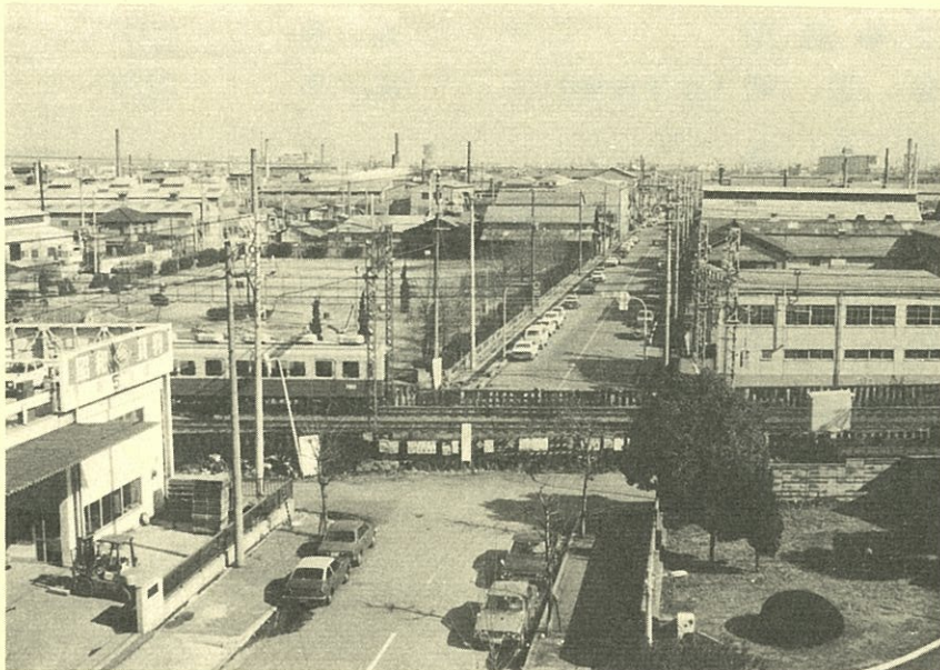
都市計画道路佃線の現況
