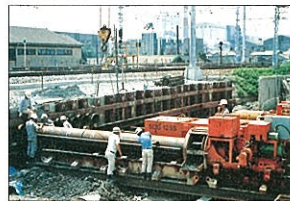
線路下に圧入される水平鋼管
