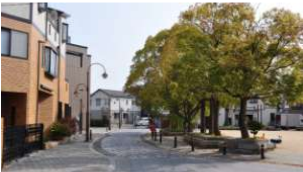
■焼け止まり線として機能した公園（神戸市）
