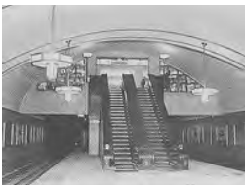
写真 完成した地下鉄駅
