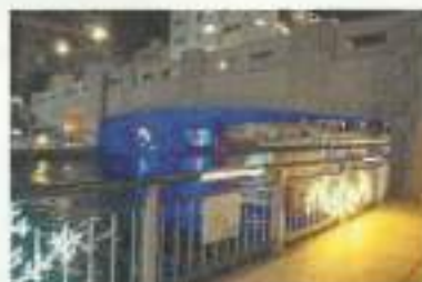
大黒橋のライトアップ
