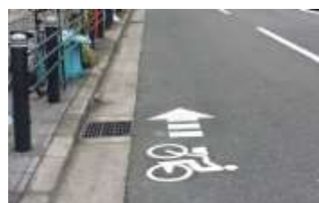
中心部の幹線道路における路面表示整備(重点整備)の例
