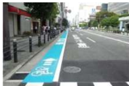
車道への自転車通行環境整備例 (本町通)
