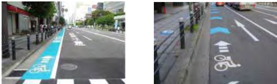
図 中心部における既存の整備事例（本町通）
