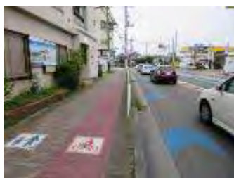
既存自歩道 + 車道混在の例(茅ヶ崎市)
