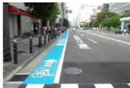
図 車道への自転車通行環境整備例 (本町通)
