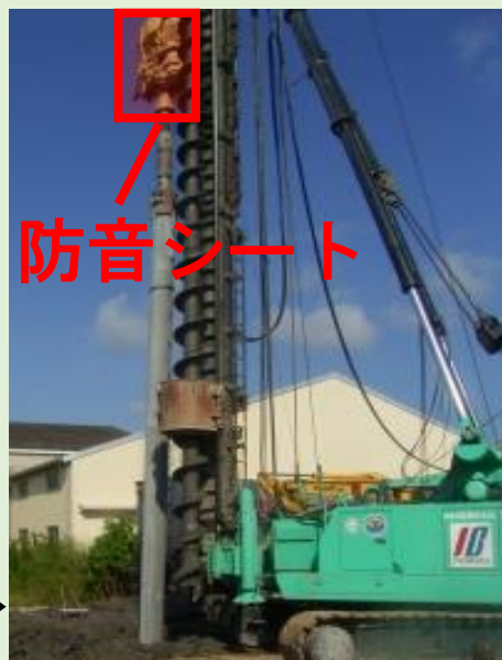
三点式杭打機→
