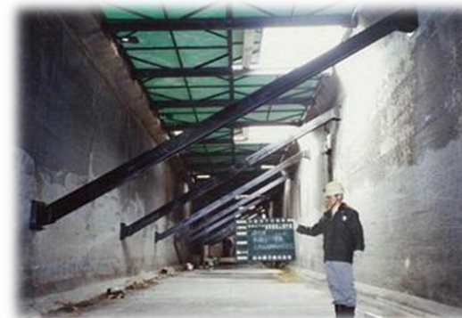
水処理施設の補強
