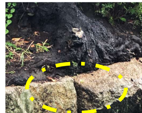
③根により擁壁が押されている状況 (将来的に損壊するおそれあり)
