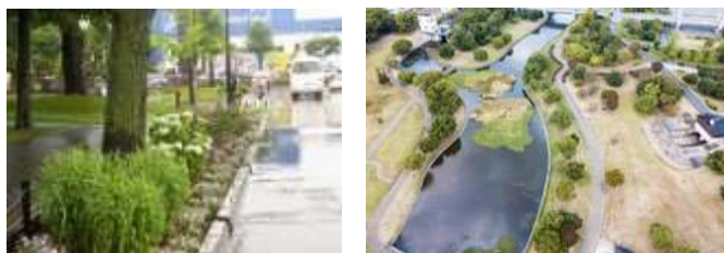
■雨水浸透機能の向上・洪水調節機能の確保（左：札幌市の雨水浸透型花壇、右：深北緑地（大阪府）の遊水地）【出典26】
