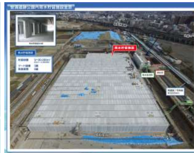
《雨水を一時貯留することで下流域の浸水被害を軽減することを目的に公園地下に雨水貯留施設を整備（高槻市安満遺跡公園）》
