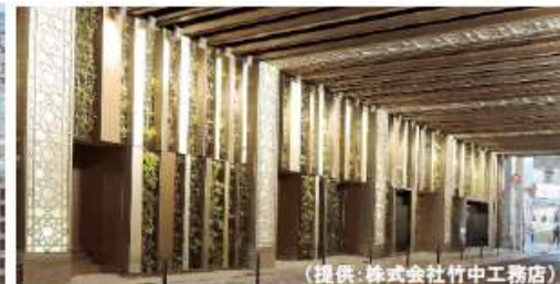
建物の間にある大宝寺通りに設けられた壁面緑化。常緑の植栽（オオイトビカツラ等）によるストライプの植栽配置。
