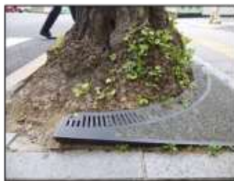
道路交通安全上に支障を来す街路樹 (左：大径木化による歩道損傷（根上り） 右：腐朽菌の侵入による倒木事故)
