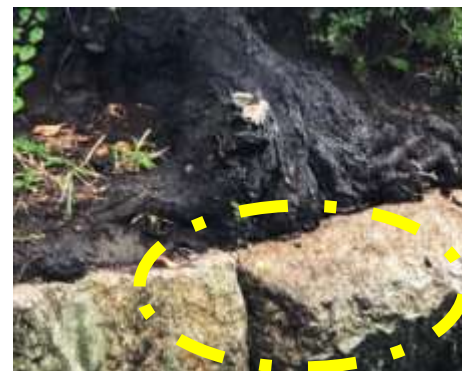
③根により擁壁が押されている状況 (将来的に損壊するおそれあり)
