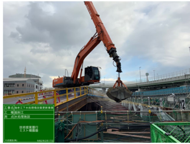
写真 4.2.7 ミスト散布（掘削時）
