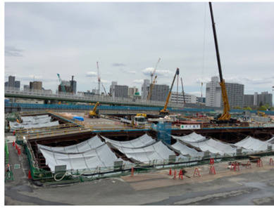
写真 4.2.6 防塵シート（掘削時）
