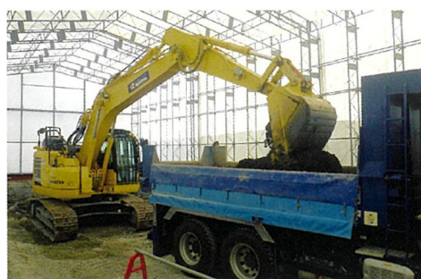
写真 4.2.3 汚染土積み込み状況
