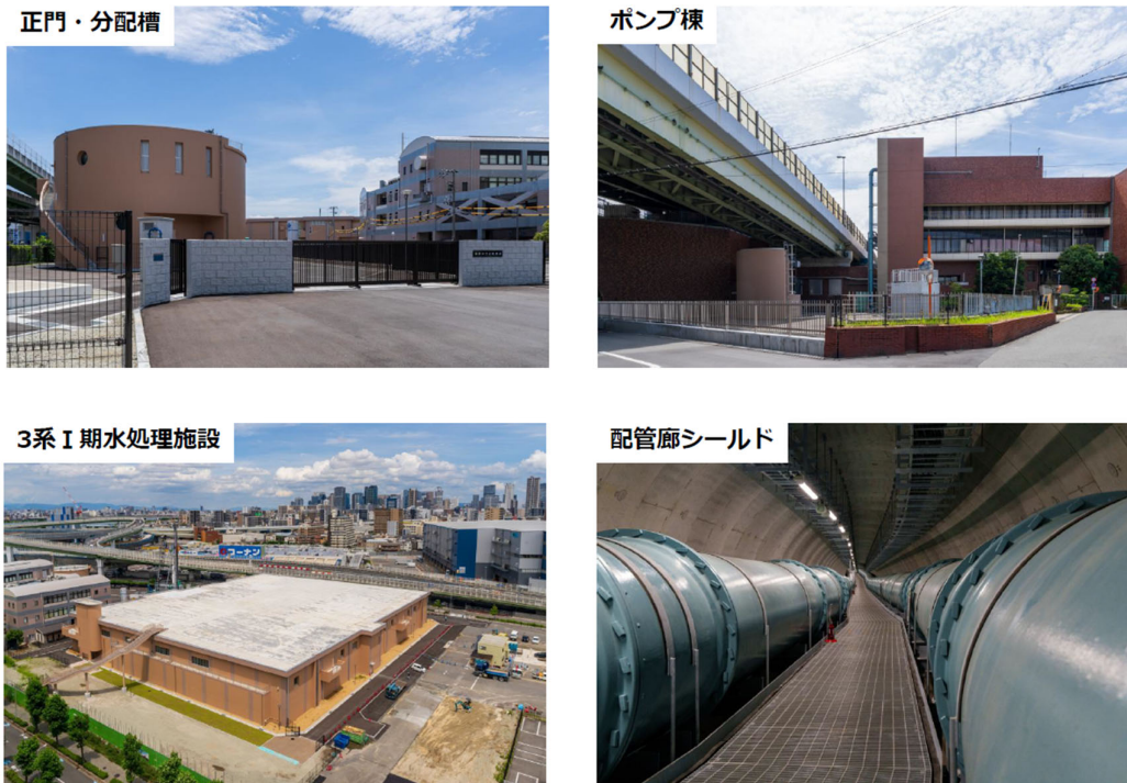
写真 4.2.1 工事完成写真
