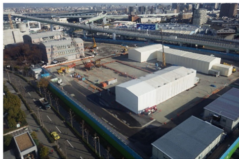
写真 4.2.2 防塵テント設置状況
