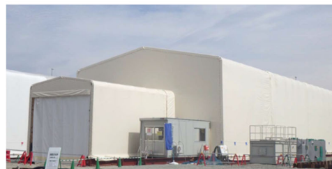
写真 4.2.2 防塵テント設置状況
