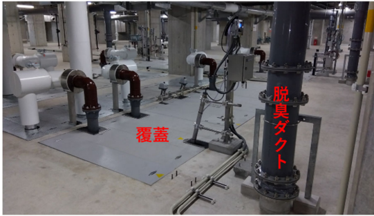
図 5.2.2 覆蓋設置及び脱臭ダクト設置状況
