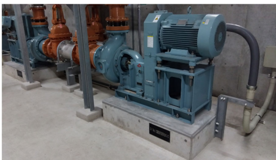
図 5.2.5 コンクリート基礎設置状況
