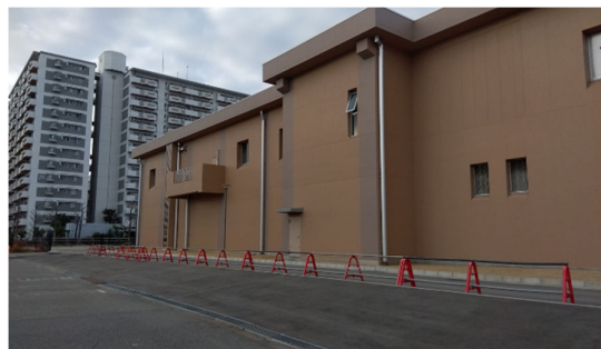
図 5.2.4 建屋の状況（水処理施設は内部）
