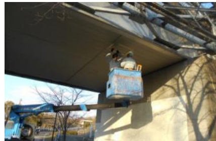
（公園橋梁の点検）
