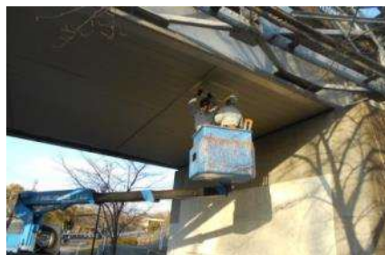
（公園橋梁の点検）
