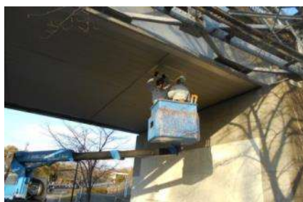
（公園橋梁の点検）
