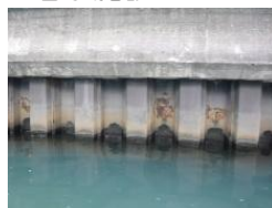
〔具体例〕 鋼矢板護岸(東横堀川)
