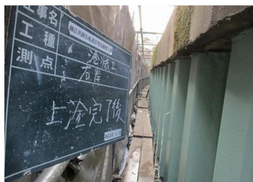
< 鋼矢板護岸 塗装後 >
