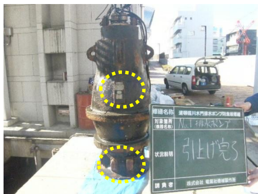
< 水門施設 部分改築（防食板取替）前 >
