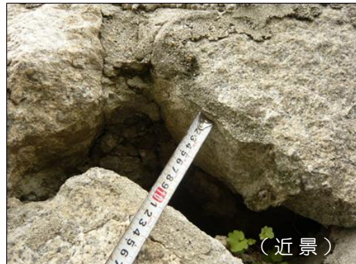
< 水防踏査点検状況（護岸変状調査） >
