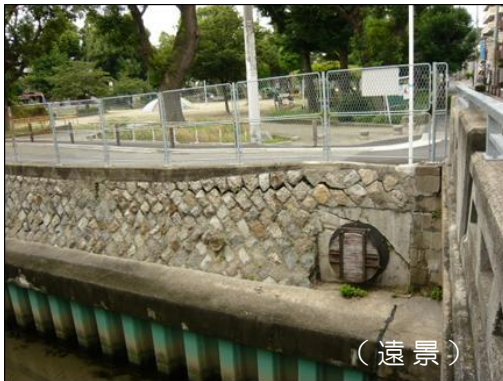
< 水防踏査点検状況（護岸変状調査） >
