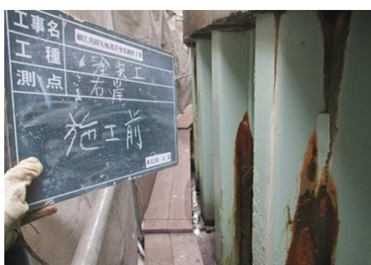
< 鋼矢板護岸 塗装前 >
