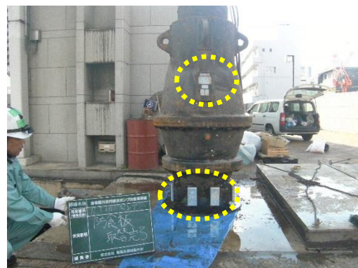
< 水門施設 部分改築（防食板取替）後 >
