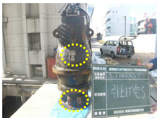
< 水門施設 部分改築（防食板取替）前 >
