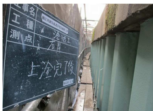
< 鋼矢板護岸 塗装後 >
