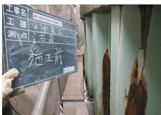
< 鋼矢板護岸 塗装前 >
