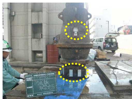
< 水門施設 部分改築（防食板取替）後 >
