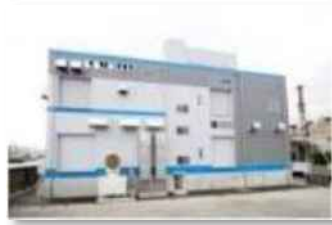
⑤消化ガス発電 （PFI事業） （津守下水処理場）
