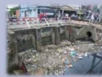
排水路の状況 （ベトナム・ホーチミン市）
