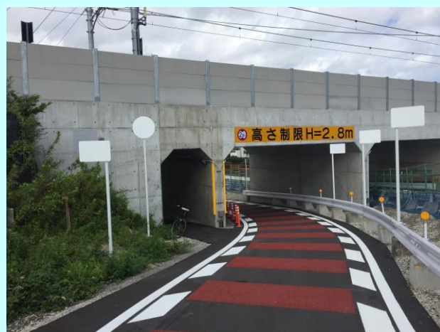
迂回仮道路（トンネル）
