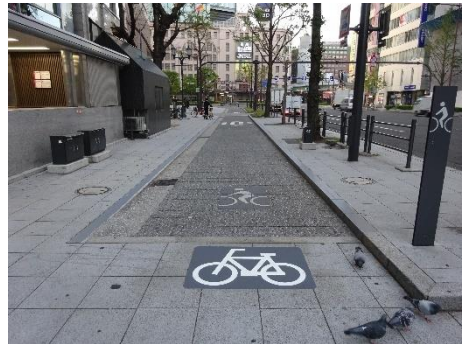
路面標示(グレー)を設置
