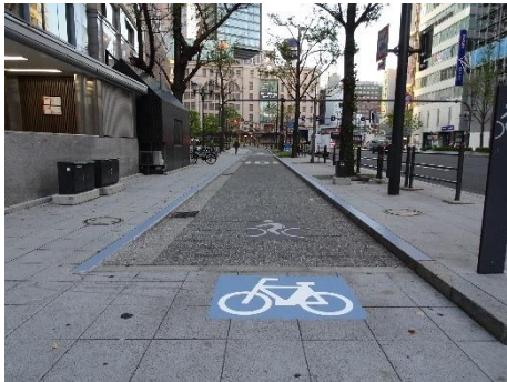
路面標示(ブルー)を設置
