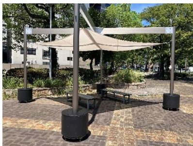
日陰棚設置状況
