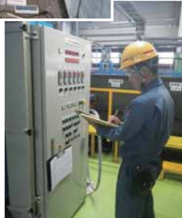
排水処理施設の稼働状況の確認
